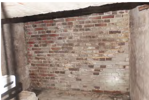
写真3 解体前の「煉瓦壁」(共同溝内)
