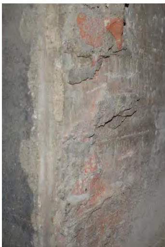
写真6 共同溝内部に残る煉瓦の痕跡
