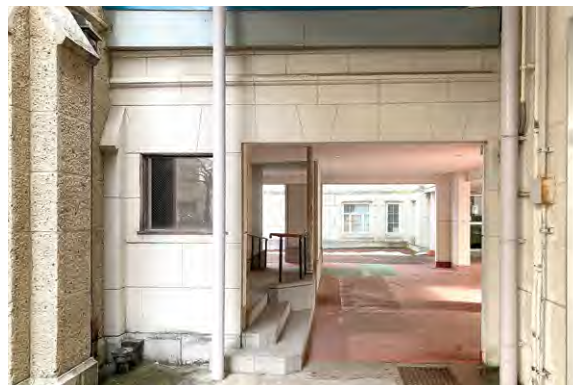
写真2 解体前の「渡り廊下」(西より写す)
