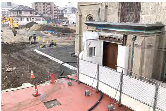
写真23 解体後の様子 (2025.1.30)
