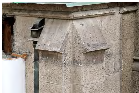
写真19 礼拝堂の外壁に見られる尖頭状の付け柱
