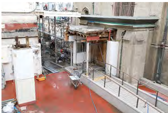
写真21 解体中の様子 (2024.8.26)
