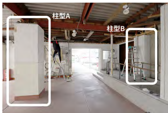
写真17 解体中の「渡り廊下」全景
