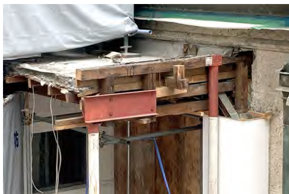
写真16 解体中の「渡り廊下」屋根
