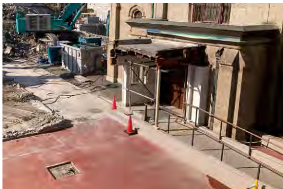
写真22 解体中の様子 (2024.11.13)
