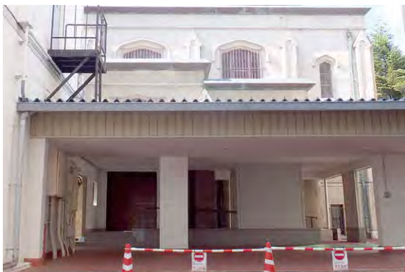
写真1 解体前の「渡り廊下」(南より写す)
