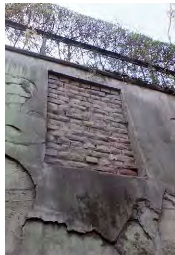
写真7 部室棟の裏に残る煉瓦壁の様子
