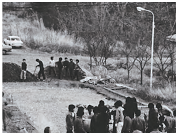
図16 土木工学科によるキャンパス自施工の様子（年不詳）
