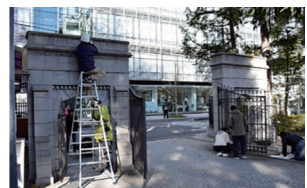
実測調査の様子
